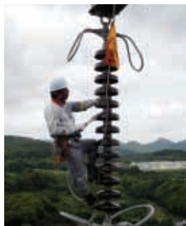
松島火力線(長崎県)がい子点検
