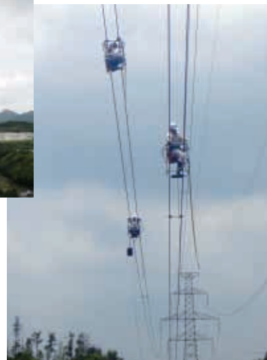
熊野幹線(奈良県)電線点検
