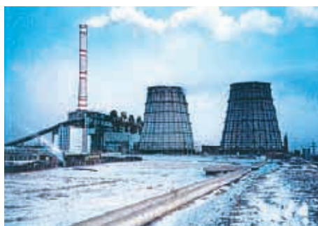
ウランバートル第4火力発電所 改修計画(モンゴル)
