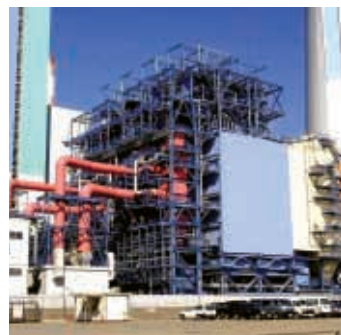
礪子火力発電所新1号機 乾式排煙脱硫装置
