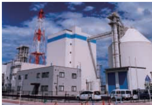
大牟田リサイクル発電事業 (非連結会社) 福岡県大牟田市: 2002年12月稼働開始 一般廃棄物RDF発電事業として、高効率廃棄物発電を行っています。
