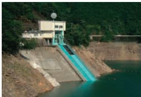
竣工時の坂本ダム表面取水設備(奈良県)
