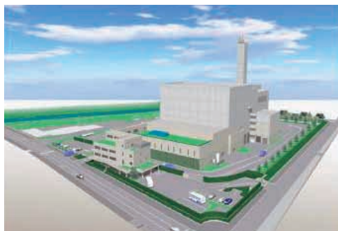
名古屋市鳴海清掃工場 (非連結会社) 愛知県名古屋市: 2009年7月運営開始予定 一般廃棄物のガス化熔融発電事業として、廃棄物発電(サーマルリサイクル)に加え、再利用によるマテリアルリサイクルも行う予定です。
