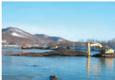
仙美里ダム堆積土砂の処理作業(北海道)
