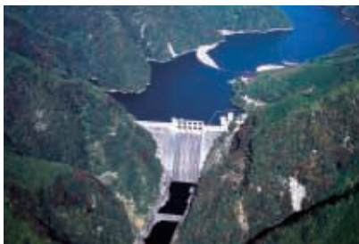
佐久間発電所(静岡県)
