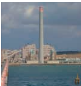
石川石炭火力発電所(沖縄県)
