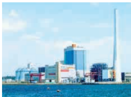
磯子火力発電所新1号機(神奈川県)
