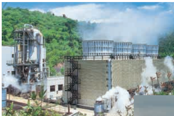
鬼首地熱発電所(宮城県)
