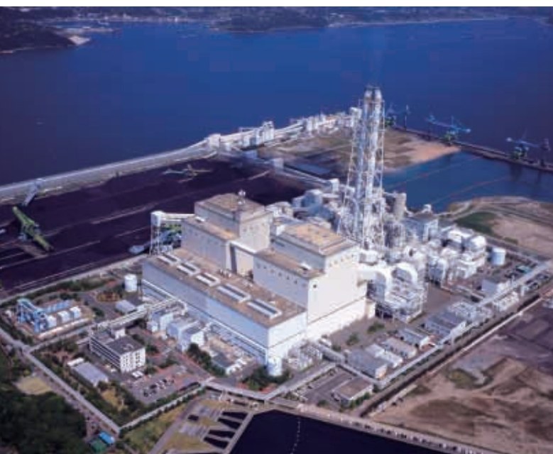
松浦火力発電所(長崎県)
