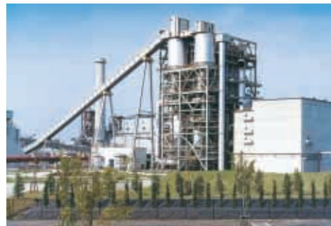
糸魚川発電所(新潟県)
