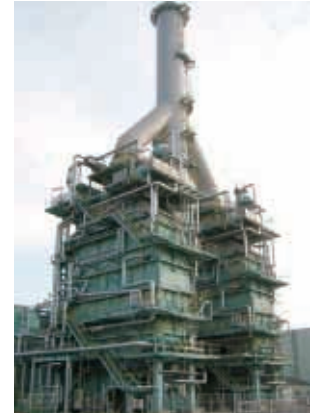
市原パワー(株)市原発電所(千葉県)
