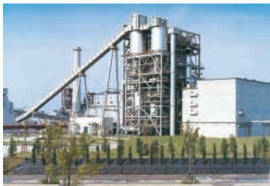
糸魚川発電所(新潟県)
