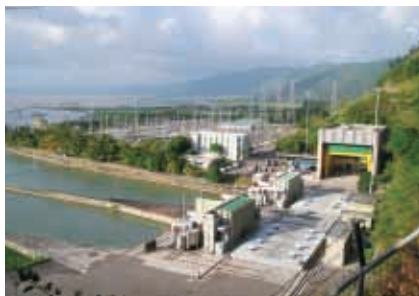
カラヤン揚水発電所(フィリピン)
