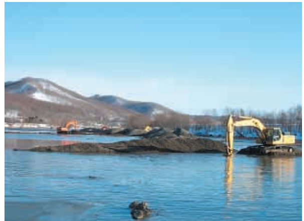
仙美里ダム堆積土砂の処理作業(北海道)
