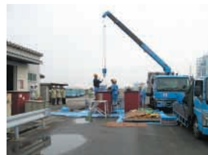
処理事業所へのPCB機器の搬出 (福岡県・若松総合事業所)
