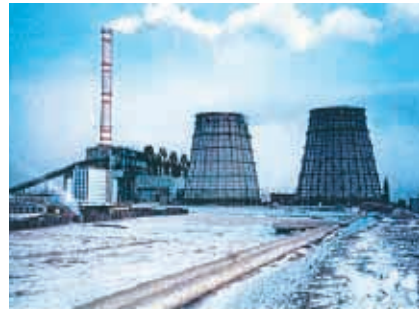
ウランバートル第4火力発電所 改修計画(モンゴル)
