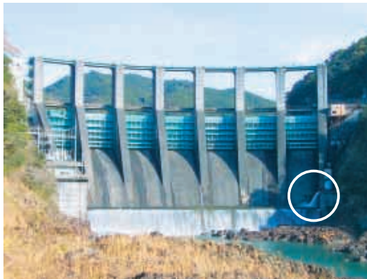
七色ダム維持流量放流(丸岡内)和歌山県・三重県)
