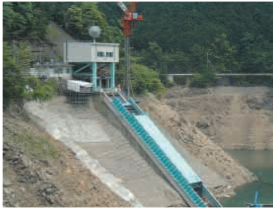
工事中の坂本ダム表面取水設備(奈良県)
