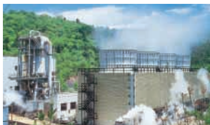
鬼首地熱発電所(宮城県)
