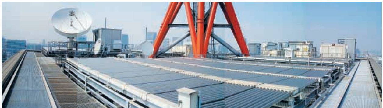
館内給湯用ソーラーパネル(東京・本店ビル屋上)
