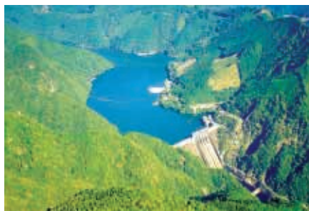
佐久間発電所(静岡県)
