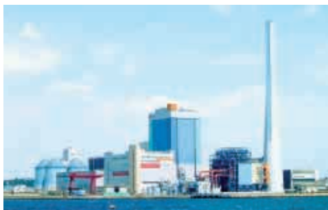
礪子火力発電所(神奈川県)
