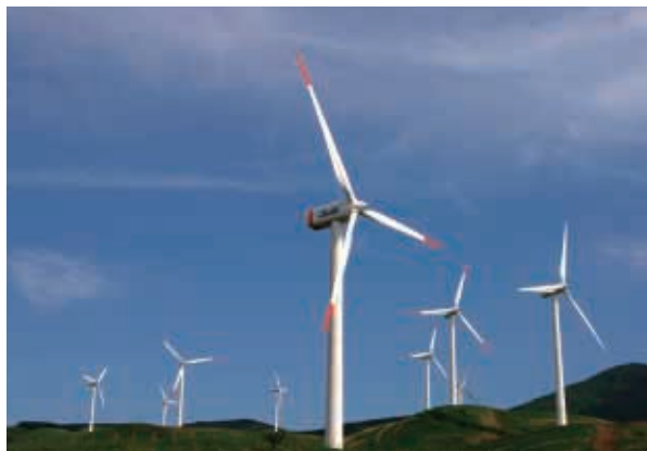
阿蘇にしはらウインドファーム 阿蘇の外輪山に位置する風力発電所。西日本の風力発電所としては有数の規模を誇ります。原野と山林からなる起伏の多い地形で、俗に「まつぼり風」と呼ばれる阿蘇山からの東風の多いエリアにあります。
