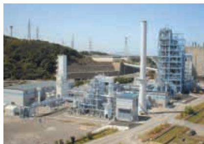
燃料電池用石炭ガス製造技術パイロットプラント(福岡県)
