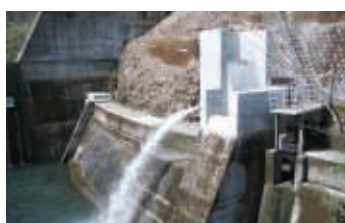
余水吐きからの河川維持流量放流(大分県・鯛生小水力発電所)
