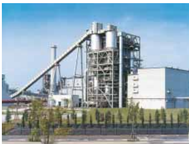
糸魚川発電所
