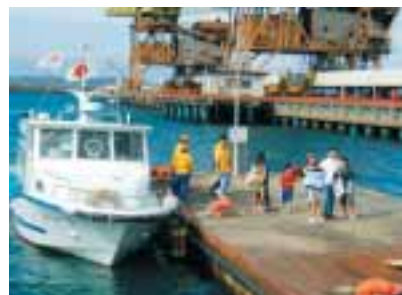
松島火力発電所(長崎県)
