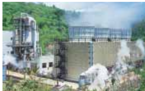
鬼首地熱発電所(宮城県)
