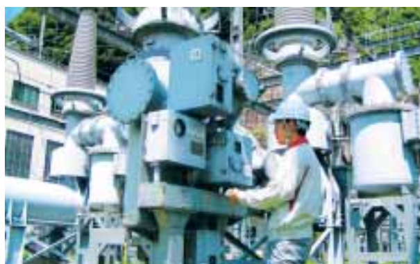
開閉器のガス圧の点検(佐久間発電所)
