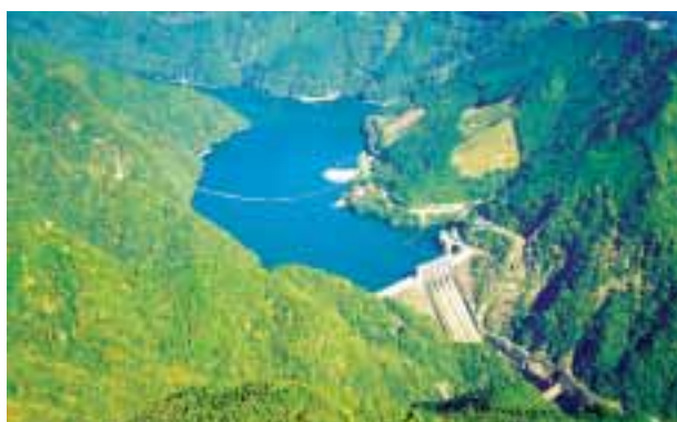
佐久間発電所(静岡県)
