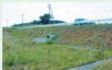
道路下の横断函渠（小動物移動用）
