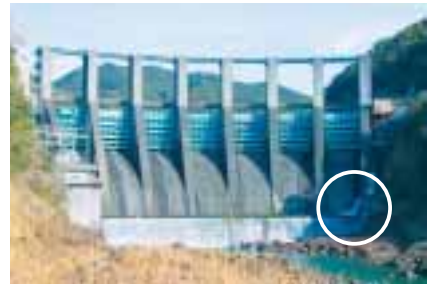
七色ダム維持流量放流(丸田内)和歌山県・三重県)
