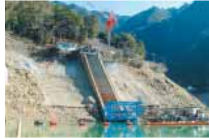
工事中の坂本ダム表面取水設備(奈良県)
