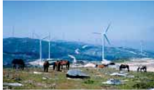
スペイン国ガリシア州の風力発電所
