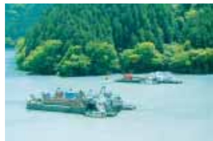
秋葉ダム堆積土砂の処理作業(静岡県)
