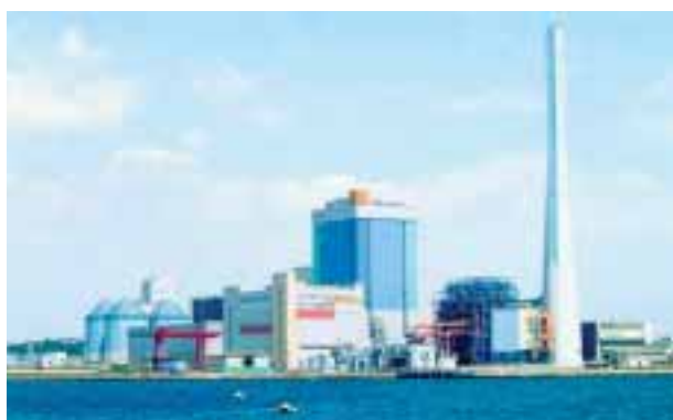
礪子火力発電所(神奈川県)
