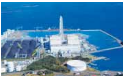
松浦火力発電所(長崎県)
