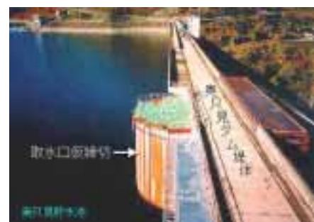
奥只見ダム仮締切工
