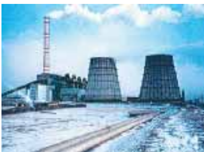
ウランバートル第4火力発電所改修計画
