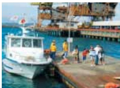
松島火力発電所(長崎県)
