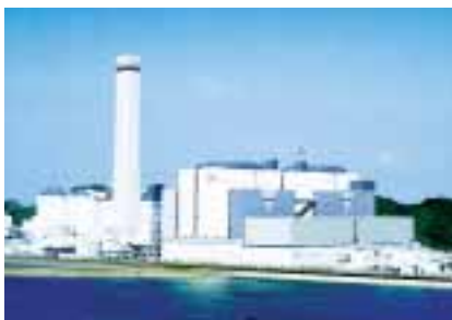
橘湾火力発電所(徳島県)
