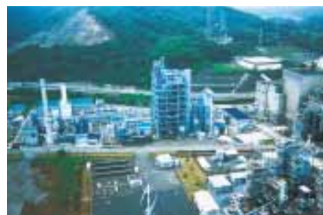
燃料電池石炭ガス化製造パイロットプラント
