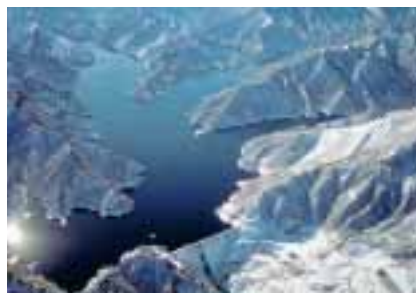
奥只見発電所(福島県・新潟県)
