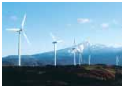
仁賀保高原風力発電所(秋田県)
