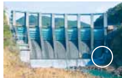
七色ダム維持流量放流(丸囲内) 和歌山県・三重県
