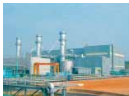
チアファイガス火力発電所
