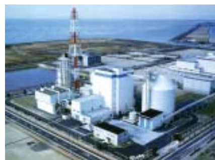
大牟田リサイクル発電所
