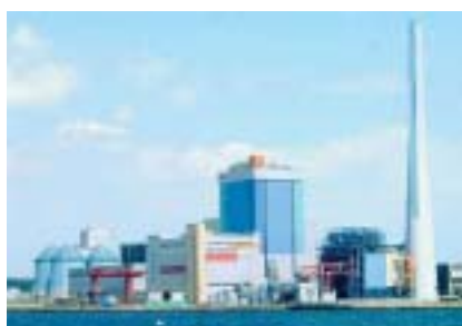
磯子火力発電所(神奈川県)
