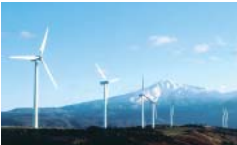
仁賀保高原風力発電所(秋田県)
