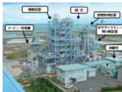
RDF利用発電技術試験装置全景
