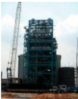
マレーシア国プライガス火力発電所
