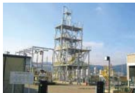
食品廃棄物からのプラスチック製造プラント
