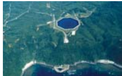
海水揚水発電技術実証試験
