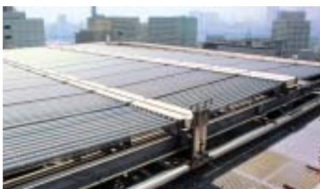
蓄熱式ヒートポンプ(本店ビル屋上)
