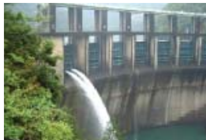
二津野ダム維持流量放流(奈良県)
