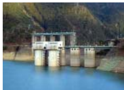
池原ダム表面取水設備(奈良県)
