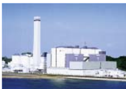
橘湾火力発電所(徳島県)
