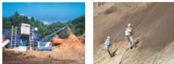
「幹等のチップ化および法面緑化工事」佐久間東幹線建替工事所(静岡県)
