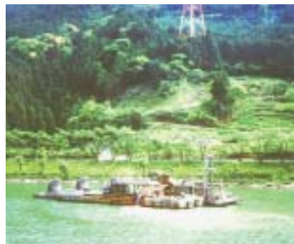
秋葉ダム堆積土砂の処理作業(静岡県)
