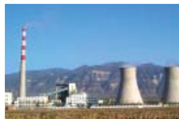
中国天石ボタ焚き火力発電所
