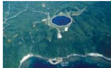
海水揚水発電技術実証試験
