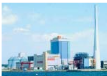
磯子火力発電所(神奈川県)
