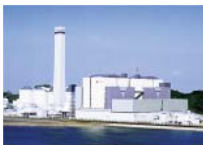
橘湾火力発電所(徳島県)
