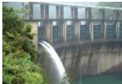
二津野ダム維持流量放流(奈良県)
