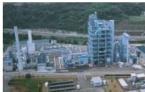
石炭ガス化燃料電池複合発電パイロットプラント
