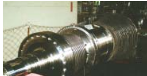
松浦2号機USCタービン
