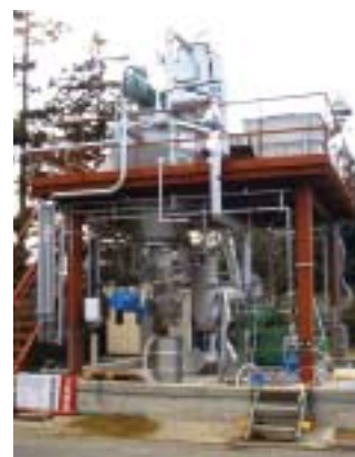
木材廃棄物からのプラスチック製造プラント
