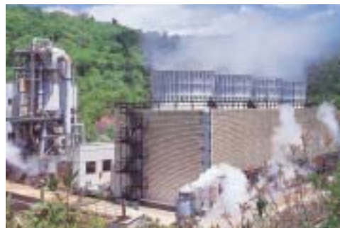
鬼首地熱発電所(宮城県)
