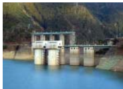
池原ダム表面取水設備(奈良県)
