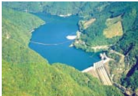
佐久間発電所(静岡県)
