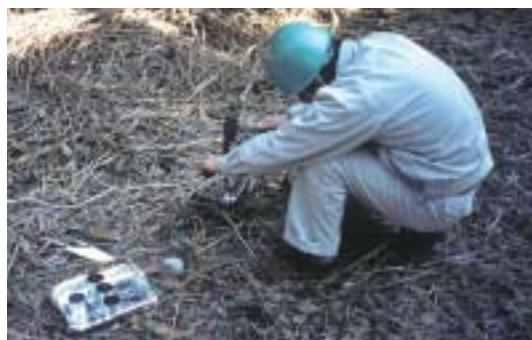
土壤汚染調査状況
