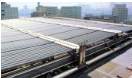
蓄熱式ヒートポンプ(本店ビル屋上)
