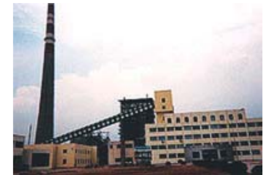
天石ボタ焼き火力発電所
