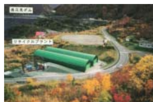
建設汚泥のリサイクルプラント
