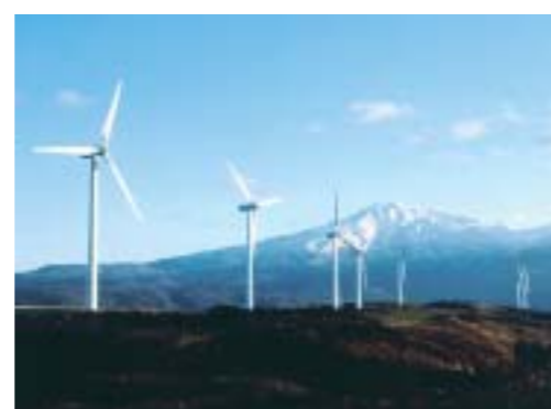
仁賀保高原風力発電所(秋田県)
