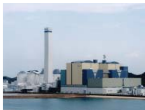
横湾火力発電所
