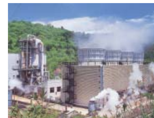
鬼首地熱発電所
