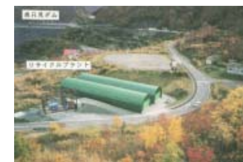
建設汚泥のリサイクルプラント
