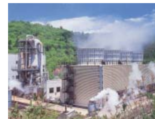
鬼首地熱発電所
