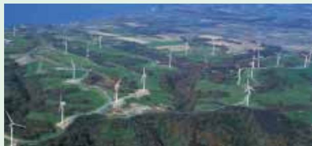
苫前ウインピラ発電所
