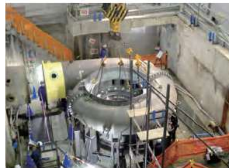
新桂沢発電所（北海道）建設工事の様子
