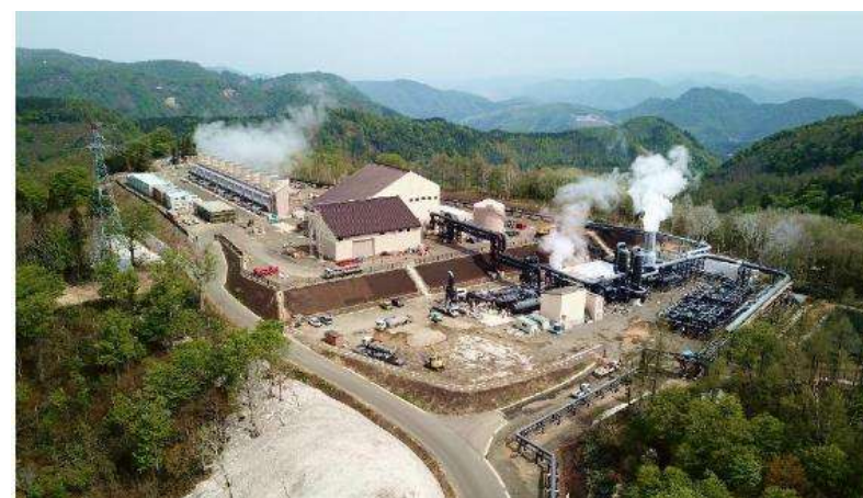
秋田県湯沢市・山葵沢地熱発電所全景
