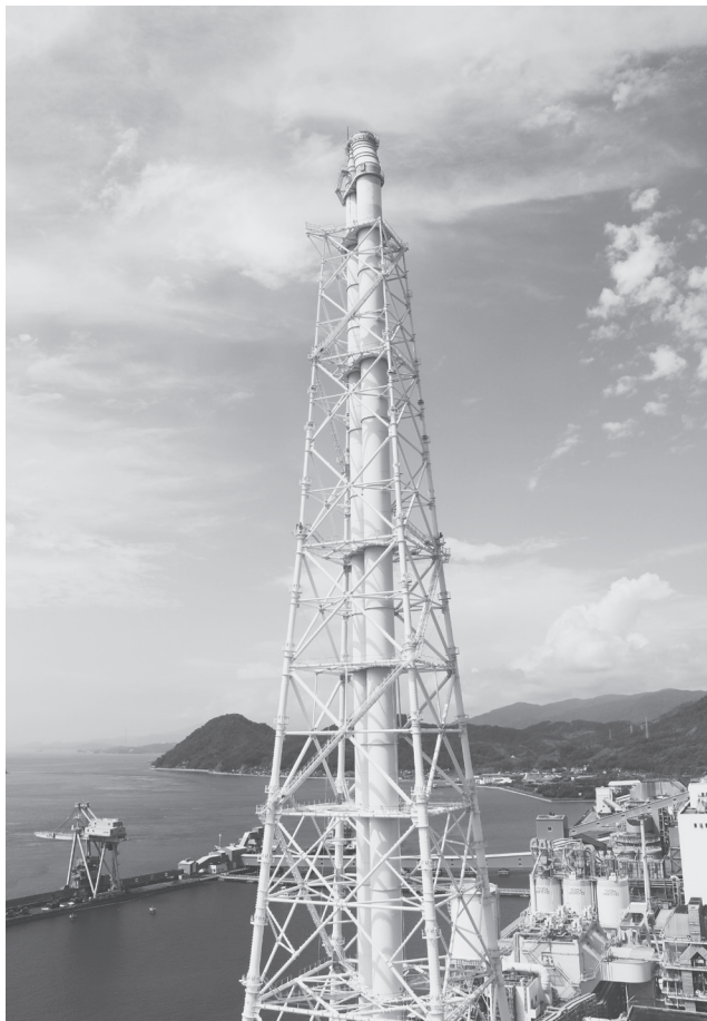
浄化された排ガスを大気へ放出する煙突。写真に写らない程の無色透明な排ガス
