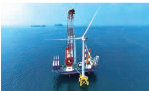
今年度完成予定の北九州響灘洋上windファーム
