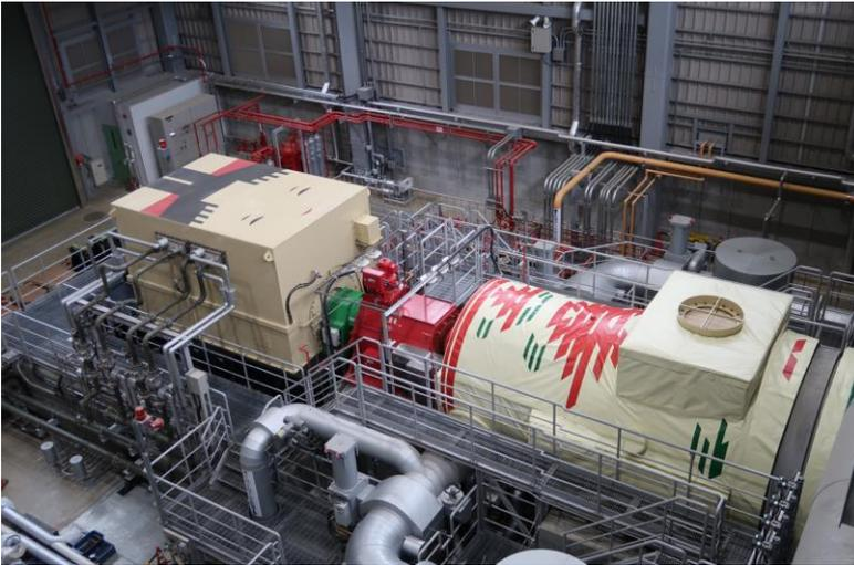
Jパワー鬼首地熱発電所は、1975年に9,000kWの出力で発電を開始し、今年で運転開始50周年を迎えました。旧鬼首地熱発電所は2017年に運転を停止し、既設設備の撤去を開始し、2019年からリプレース工事を進め、2023年4月に出力14,900kWの新しい鬼首地熱発電所として、生まれ変わりました。
