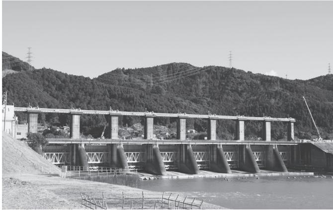
船明ダム。一つ約300トン(巻上機含)の9枚のゲートが目を引き
