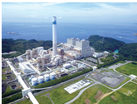
2号機に石炭ガス化設備を付加する予定の松島火力発電所
