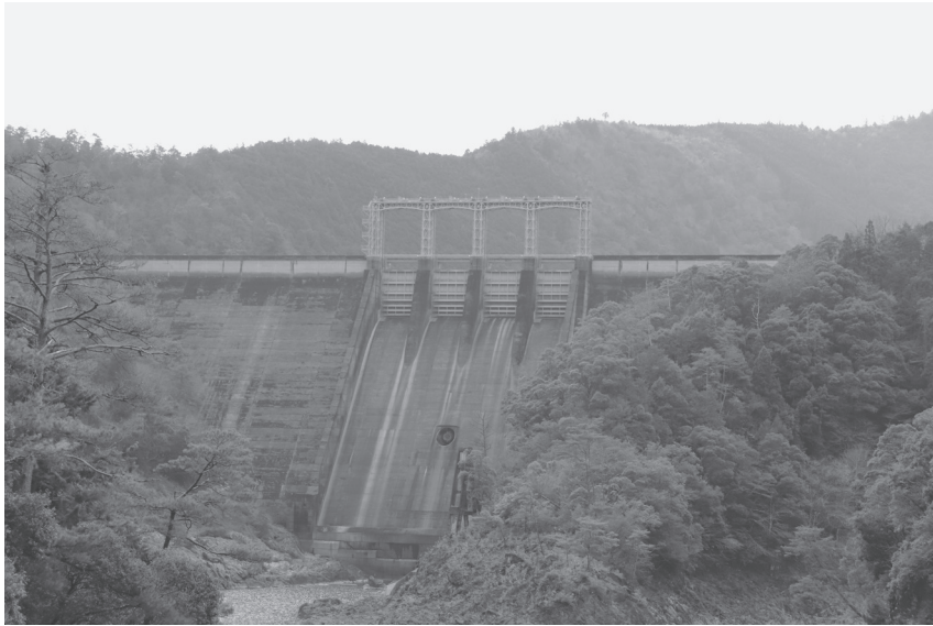
風屋ダム。遠くから見ても、どしんと構えた迫力のあるダムだ。
