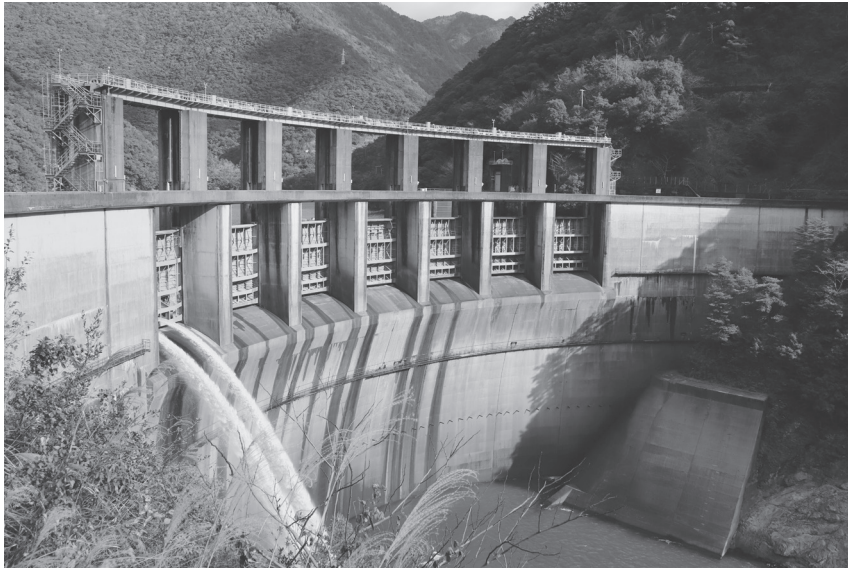
二津野ダム。これぞまさにアーチダムという堂々たる風貌を感じる。
