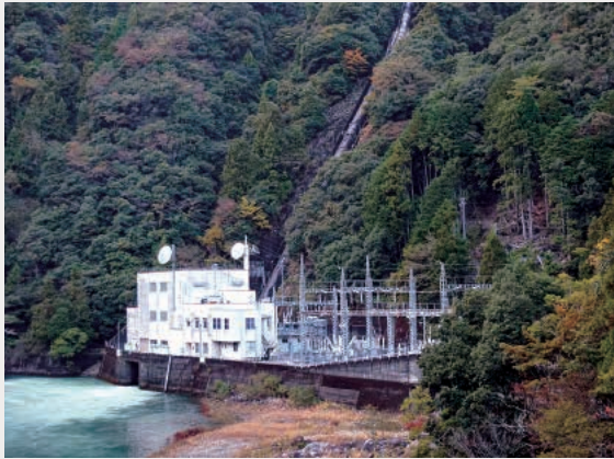
有効落差225.3mの尾鷲第一発電所
