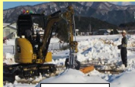
無線重機訓練
