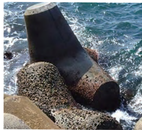
「石炭灰重量モルタルブロック」(上)設置8か月後の海藻付着状況
