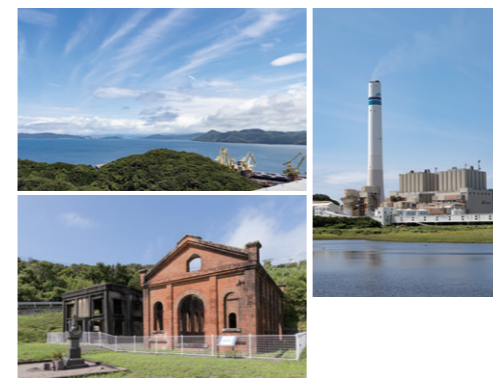
松島の西方洋上には五島列島や平戸島の遠景が浮かぶ。ハウステンボスとほぼ同じ面積の松島火力発電所の約半分は緑地。自然と共生する設備でもある。島内にはかつての炭鉱の姿を唯一遺す赤煉瓦の第4坑跡も。
