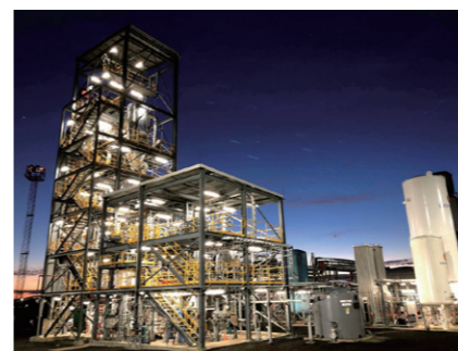
70年におよぶ技術革新の歴史で培われた総合力をもとに、カーボンニュートラル実現への具体的なプランを策定。水素社会も視野に入れた活動を推進中。写真：豪州褐炭水素製造実証設備
