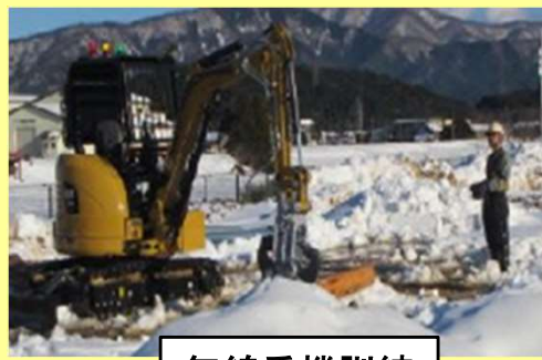
無線重機訓練
