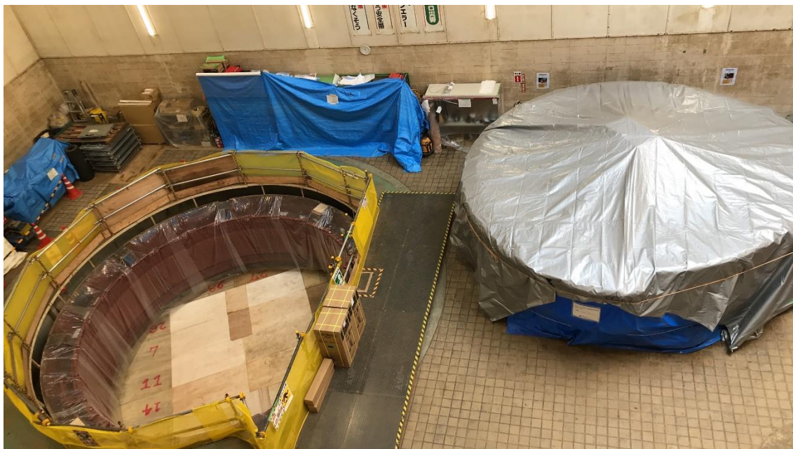
写真-2 発電所内発電機補修状況 (2021 年 6 月撮影)
