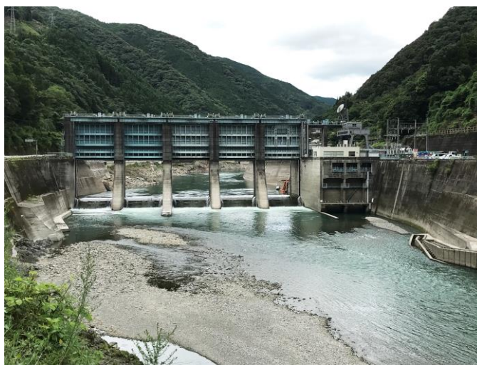
写真-1 瀬戸石ダム下流状況 (2021年7月撮影)
