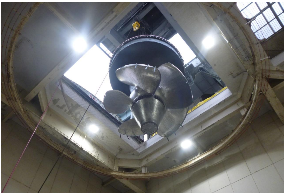
写真-1 点検完了後水車吊り込み状況 (2021 年 5 月撮影)
