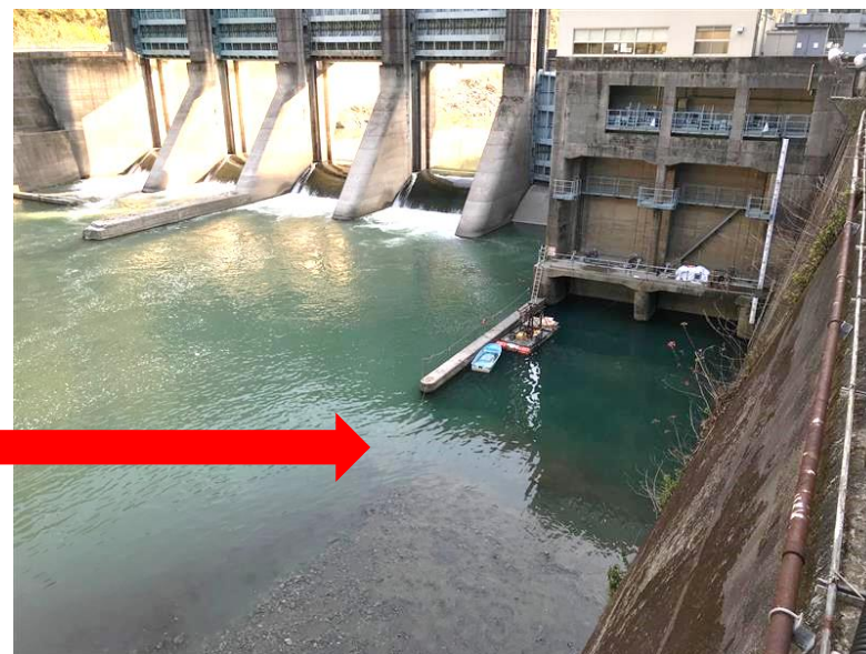
② 土砂排除後(2021年3月)
