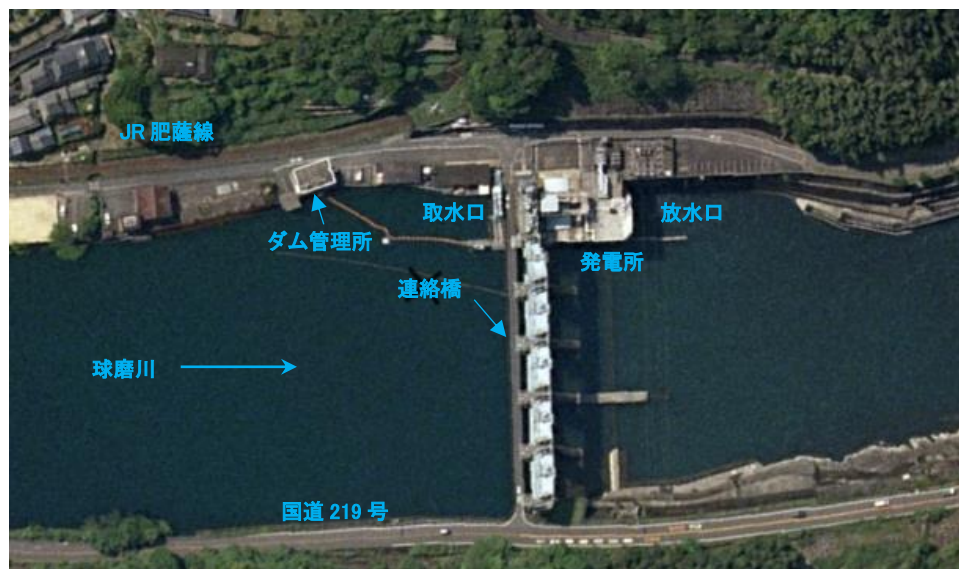
瀬戸石ダム(全景)
