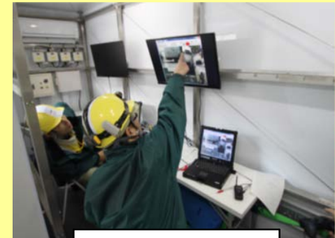
発電所内での訓練
