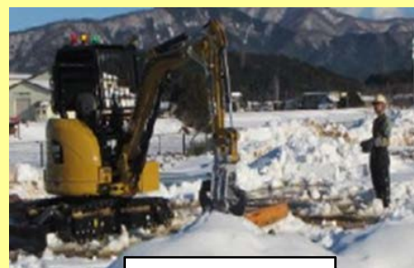
無線重機訓練
