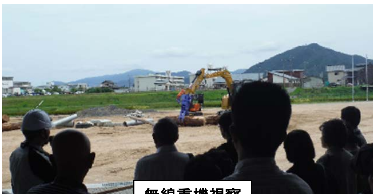
無線重機視察
