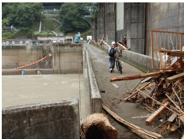
連絡橋 流木撤去前 (7月13日)
