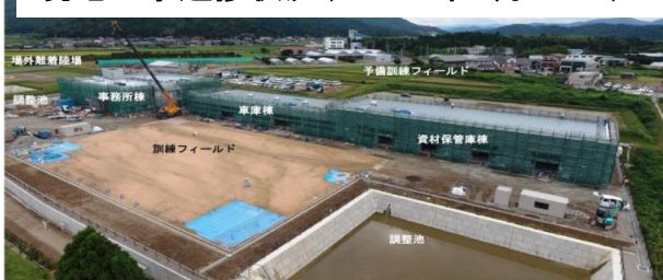
現地工事進捗状況(2016年9月27日)
