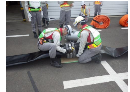
ホース敷設・接続訓練
