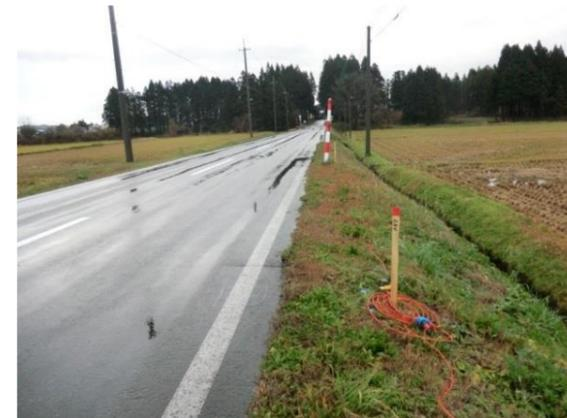
図5 受振器の設置状況(事例)
