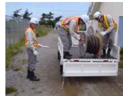
ケーブル敷設訓練
