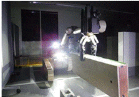
暗闇での障害物撤去
