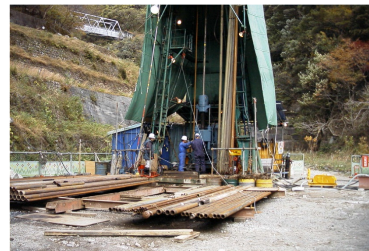
図4 大深度ボーリング作業状況（事例）
