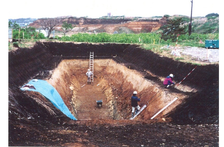
図5 トレンチ調査作業状況（事例）
