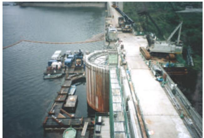
写真 - 1 仮締切施工状況
