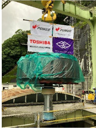
長山発電所1号機リパワリング工事の様子（回転子吊込み）
