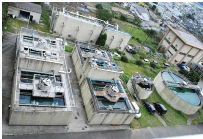
【上寺浄水場 全景】
