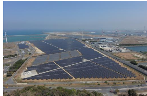
ドローンによる空撮写真
