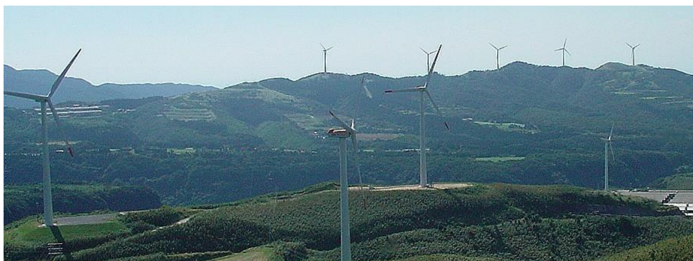
<南大隅ウインドファーム（更新前設備・撤去済）>
