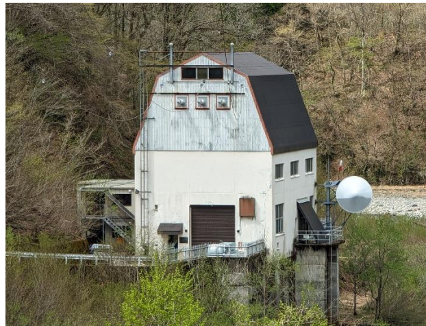
尾上郷発電所（全景）
