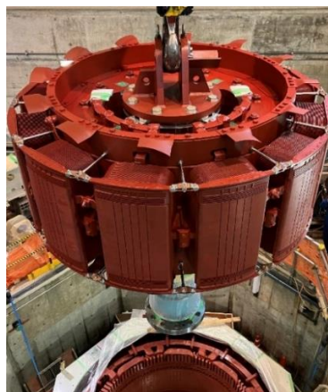
尾上郷発電所（新発電機回転子吊り込み）
