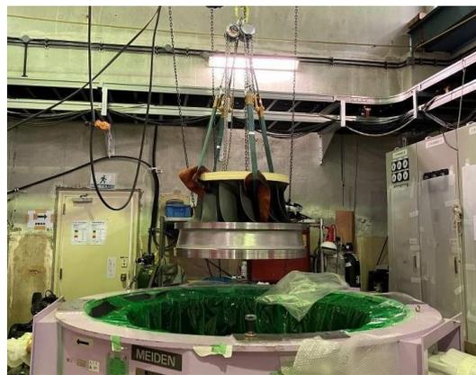
2号機新型水車ランナ吊り込み
